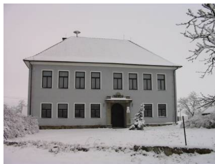
Kulturní dům, dříve škola
